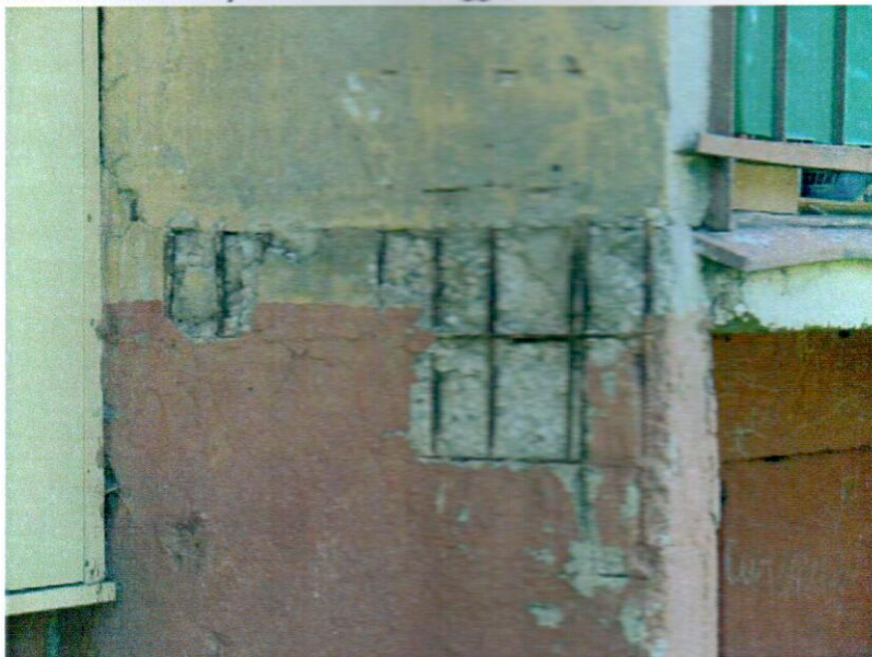
d) odsłonięte węzły konstrukcyjne ze skorodowanym zbrojeniem.
