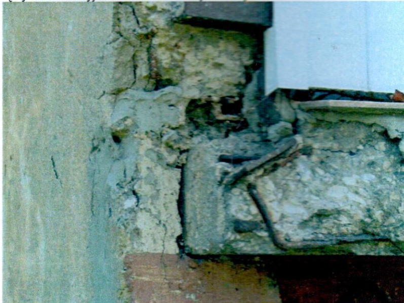
d) odsłonięte węzły konstrukcyjne ze skorodowanym zbrojeniem.
